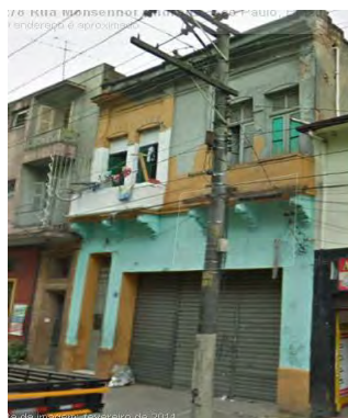
Rua Monsenhor de Andrade, situação atual do imóvel
